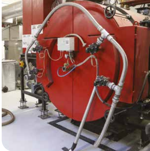
Une chaudière bois plaquettes forestières ins- tallée rues L.Blum, L.Braille, Verdun et JH.Mansart à Belfort
