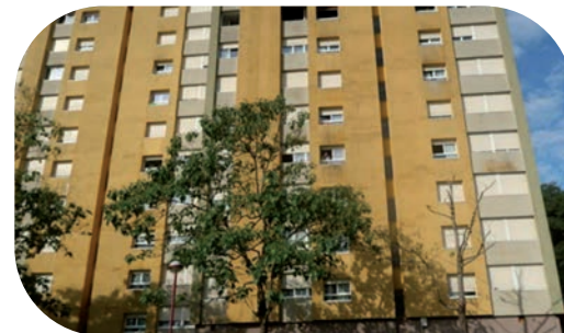
Incendie au 8 e étage rue Parant à Belfort le 17 août 2023 (photo Est Républicain - Pascal Chevillot)
