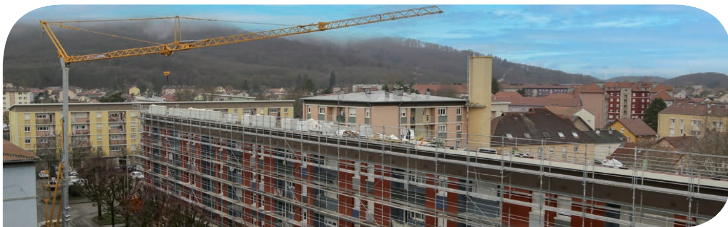
Travaux de la rue de Giromagny à Belfort
