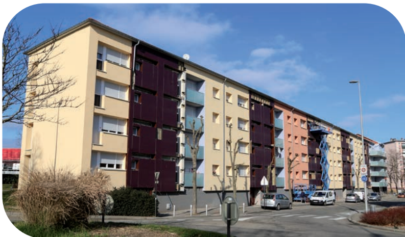
Réhabilitation rue Blum à Belfort
