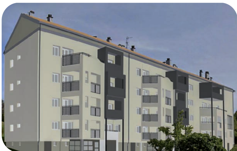
Delle (40 logements) • Architecte : S&Bau
